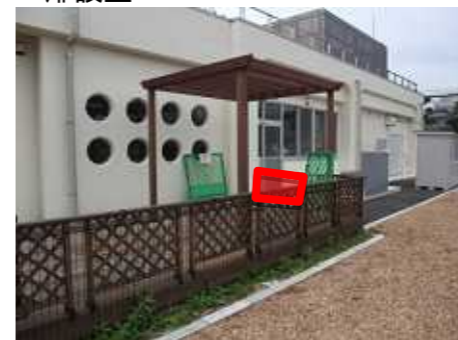
門扉設置 (3箇所) -1
